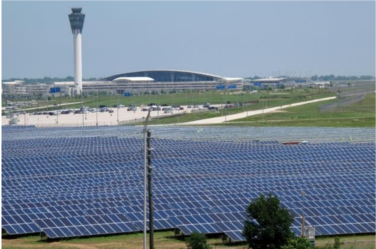
Figura 12 Parque fotovoltaico anexo al aeropuerto internacional de Indianápolis, en EE.UU.
